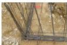
Nœud de chaînage - Continuité mécanique
