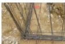
Nœud de chaînage - Continuité mécanique
