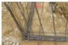
Nœud de chaînage - Continuité mécanique
