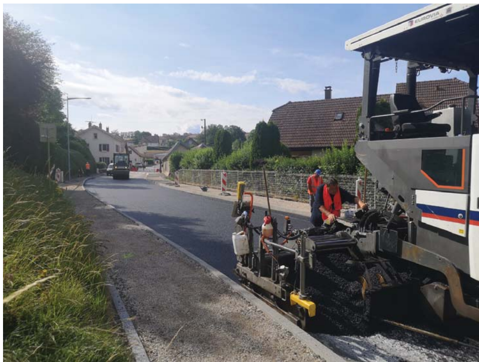
La deuxième tranche de réhabilitation de la rue de Beaucourt s'est terminée en 2023 par la pose de l'enrobé final.
