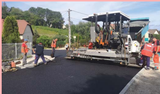
Travaux rue de Beaucourt : le début et la fin.
