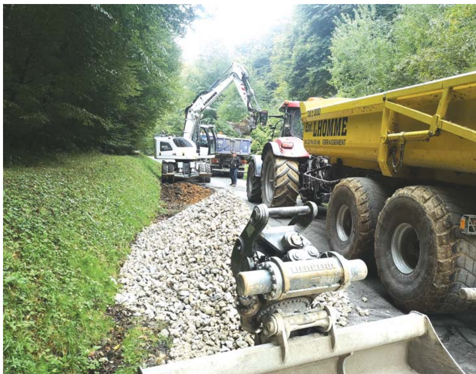
Avant la pose de l'enrobé, l'entreprise Climent a procédé au reprofilage de la chaussée.
