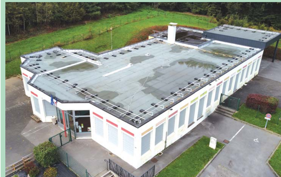
La toiture de l'école, photographiée par Gilles Valdenaire avec un drone.
