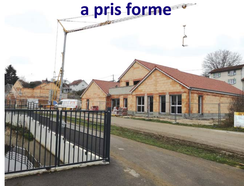
La construction des deux maisons Âges et Vie est déjà bien avancée.
