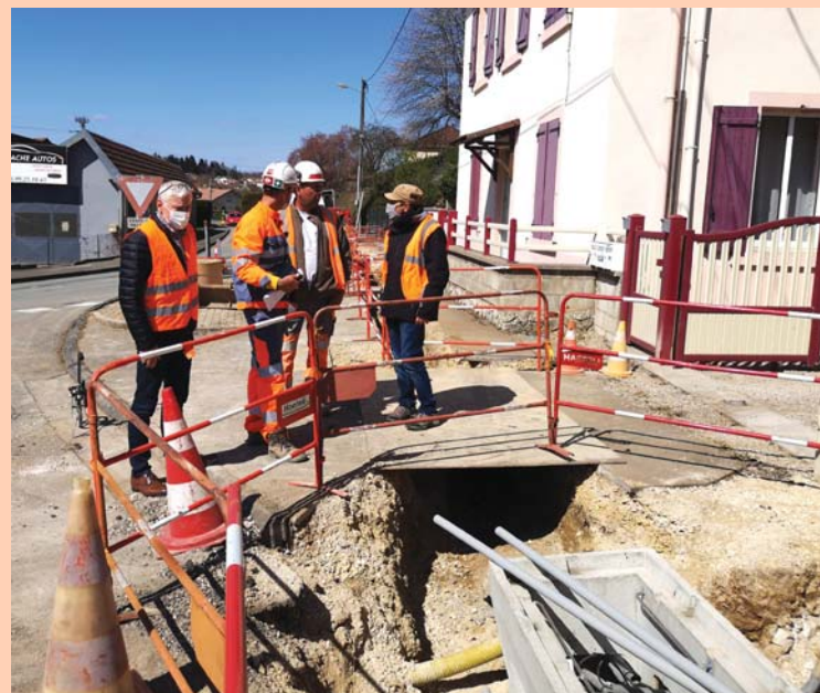
Mars : début des travaux d'électrification rue de Beaucourt.
