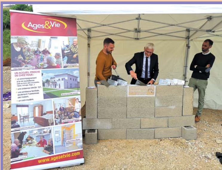
Juillet : pose de la première pierre de la maison Âges et Vie.
