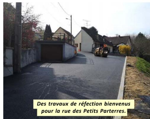
En début d'année, la rue des Petits Parterres, passablement dégradée suite aux travaux d'assainissement réalisés en 2018, a été rénovée. La structure de chaussée a été refaite et la pose d'un enrobé a parachevé le chantier. Un mur de soutènement a également été construit côté rue de la Combe. L'investissement s'élève à environ 90.000 €.
