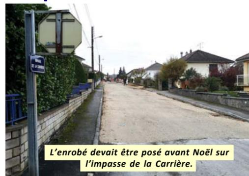
Au printemps 2018, l'impasse de la Carrière avait fait l'objet d'importants travaux d'assainissement avec l'installation d'un réseau séparatif sur les 280 mètres linéaires de la rue. Une réfection sommaire de la chaussée avait été faite dans un premier temps.
