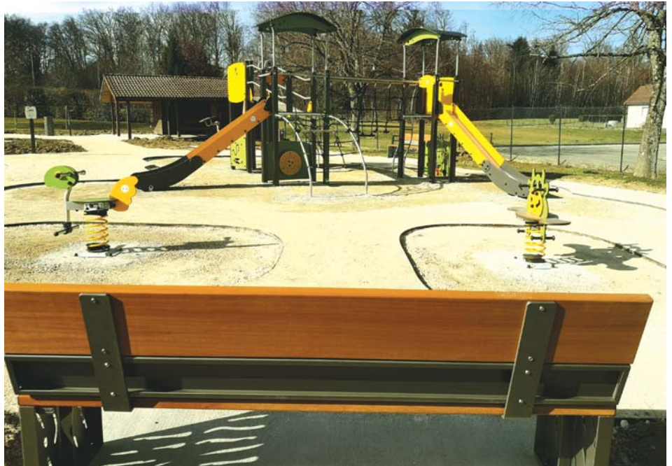
La nouvelle aire de jeux en construction.
