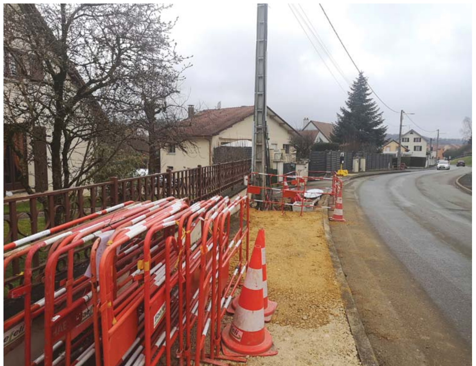
Les travaux d'enfouissement des réseaux secs ont débuté sur la deuxième tranche de la rue de Beaucourt.
