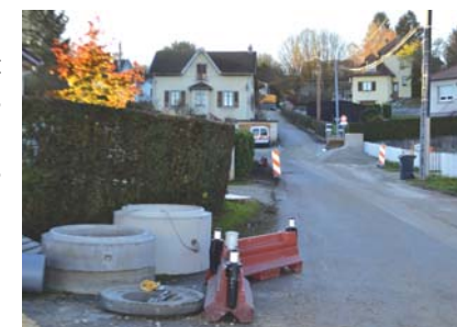
Les travaux de la rue de la Rougeole et de la rue des Sapins.
