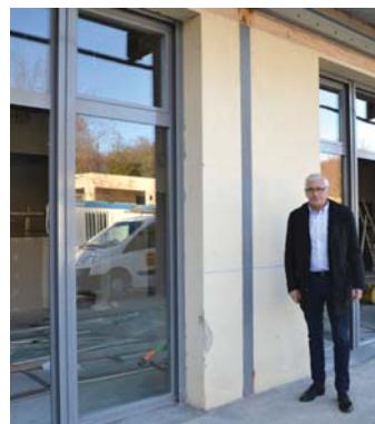
Les fermetures extérieures sont en place.
