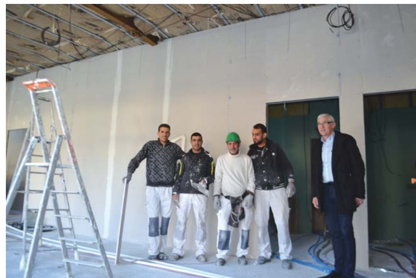
Les entreprises travaillent sur les aménagements intérieurs.
