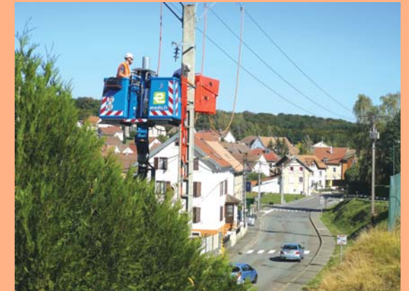
Les intervenants d'ENEDIS sur le poteau de la rue de Beaucourt
