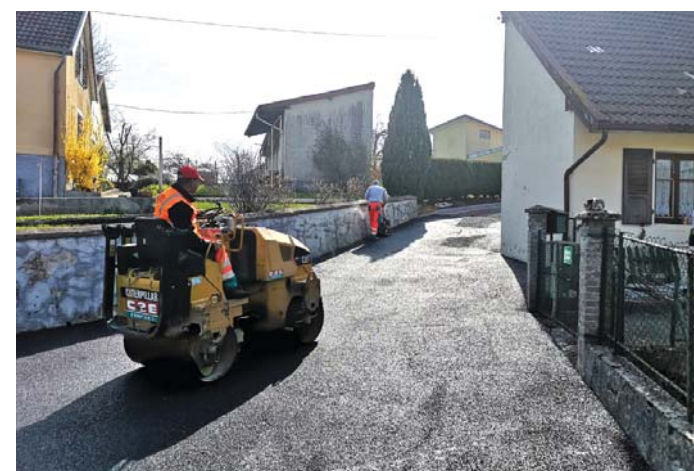
Une rue toute neuve pour les riverains des Petits Parterres.
