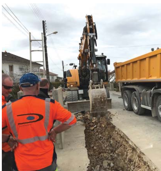
Les travaux perturbent quelque peu la circulation dans l'impasse de la Carrière.
