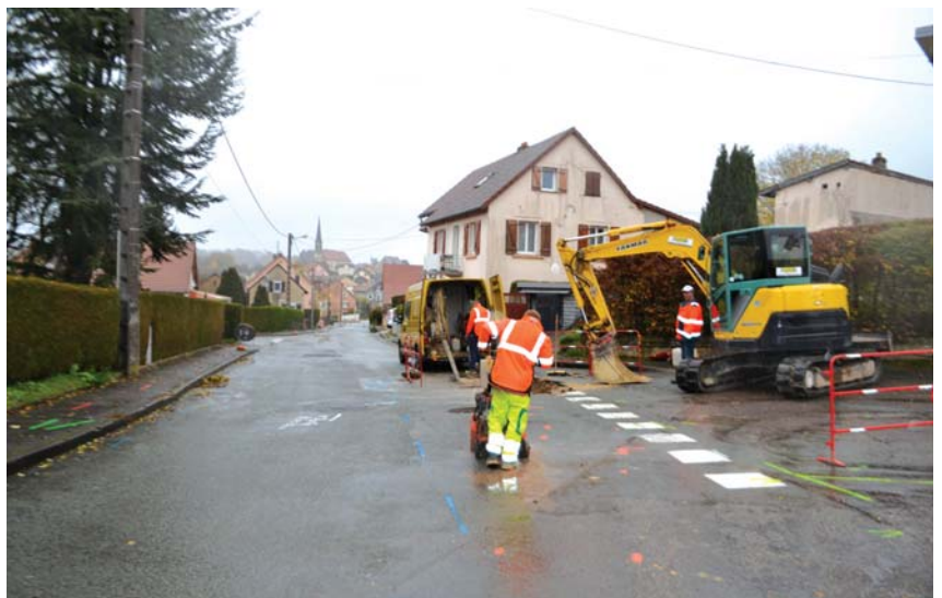
Les travaux ont débuté le 13 novembre rue de la Rougeole.
