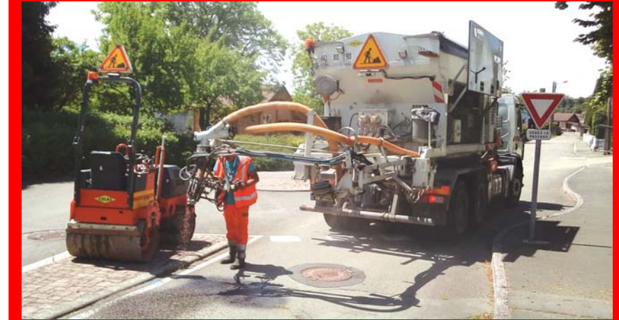
Une nouvelle technique pour le rebouchage de trous sur les routes.
