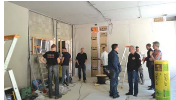
La future salle de classe en cours d'aménagement.
