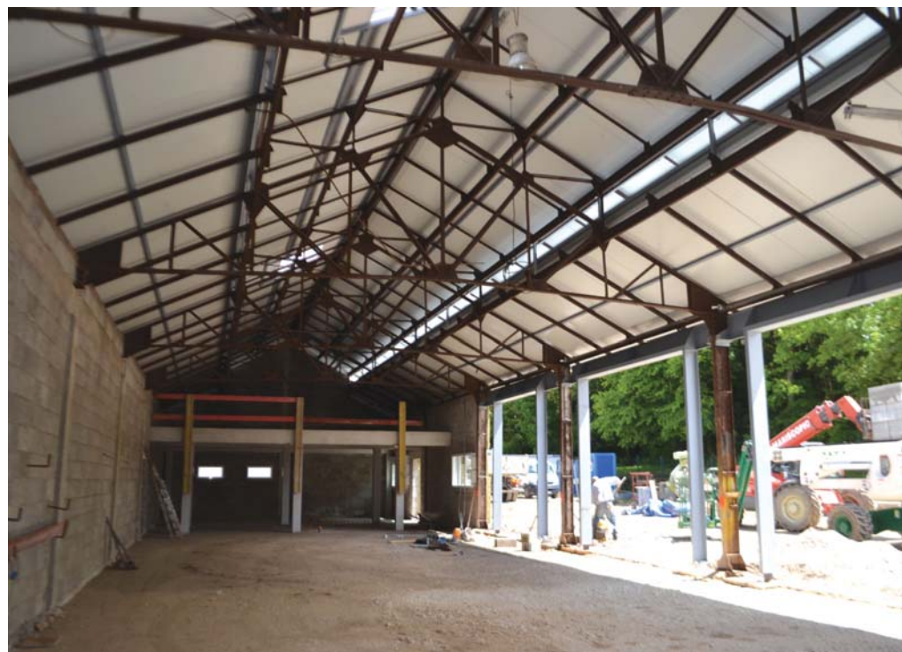
Déjà revêtu d'une toiture neuve en bacs acier, l'ancien bâtiment Concastri est aménagé pour abriter les ateliers municipaux.
