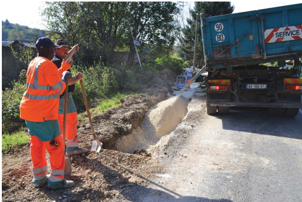
Importants travaux d'assainissement sur toute la traversée du secteur du Gros-Pré.
