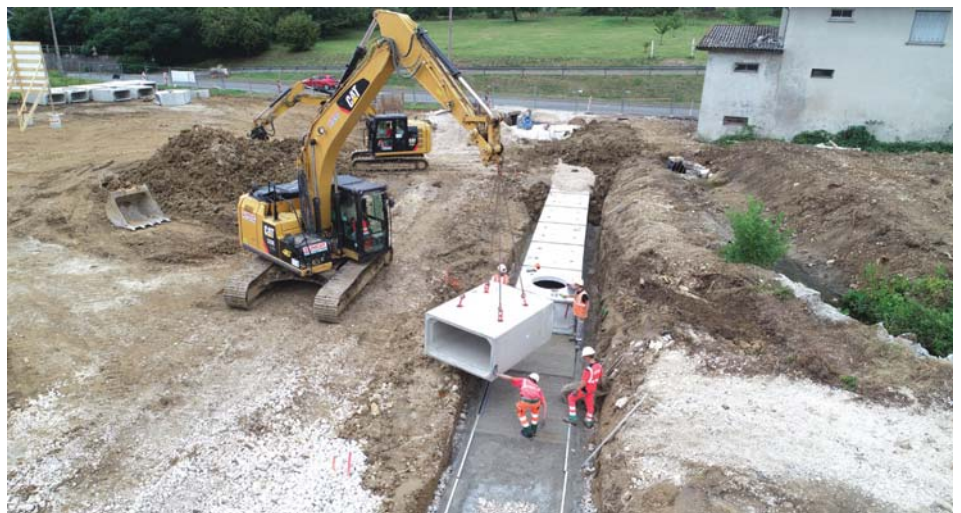
Installation des réseaux d'eau potable et d'assainissement par l'entreprise Climent.
