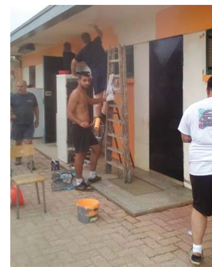
Coup de jeune pour les façades des vestiaires.
