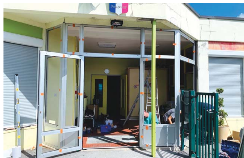
La baie vitrée de l'entrée a été remplacée.
